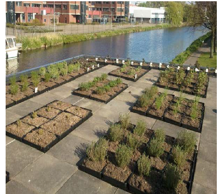
Figure 17 - Rooftop garden, CooperatiefEigenwijzer
