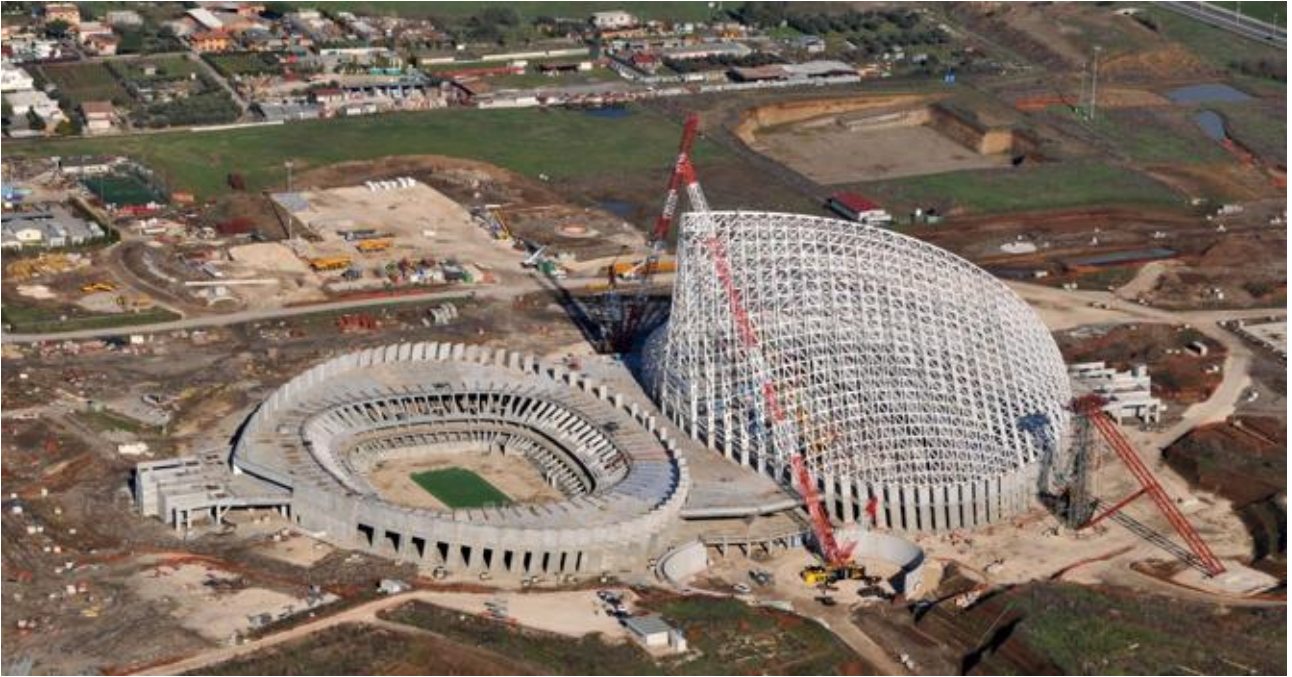
Figura 8 Le Vele di Calatrava oggi 14
