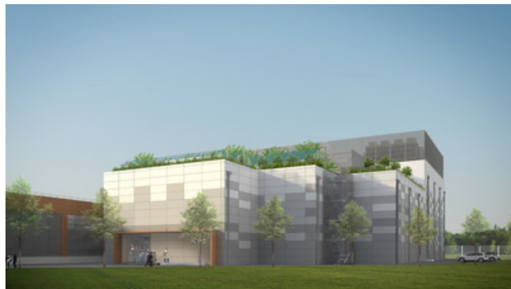
Figura 10: Il data center MU4 di Equinix ad Aschheim, Germania
