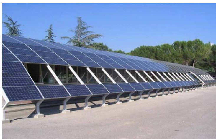
Figura 17: Impianto localizzato nel comune di Narni (TR), costituito da 252 moduli di potenza unitaria, pari a 160 W. Producibilità annua: 52.800 kWh.
